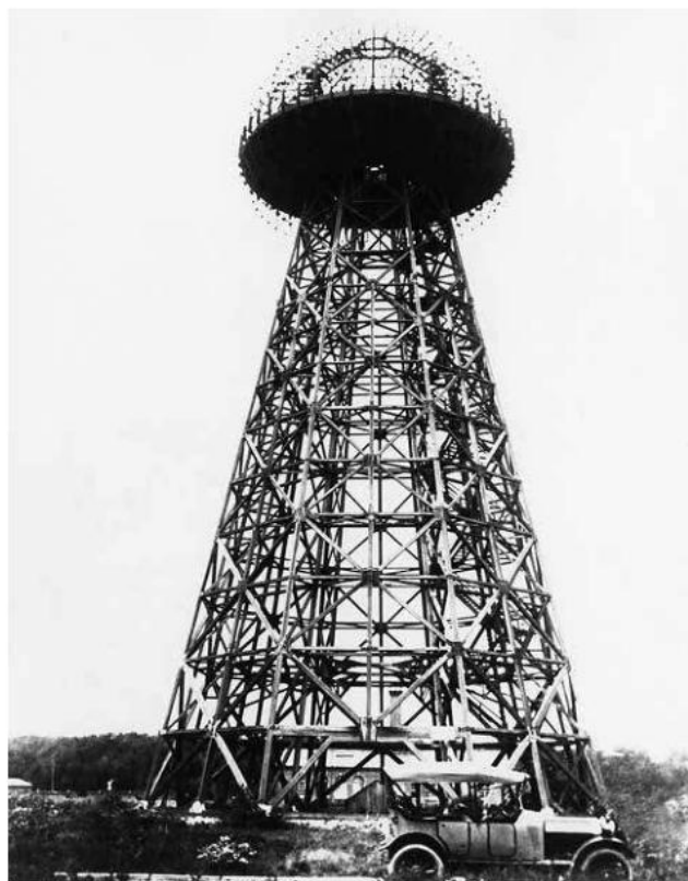
▲ Башня «Ворденклифф» для беспроводной передачи на большие расстояния электрических сигналов и электрической энергии была уже построена, оставалось закончить монтаж купола, но в это время финансирование проекта прекратилось. Купол так и остался недоделанным: удалось смонтировать только его каркас. Интересно, что точка, где произошло тунгусское событие, находится практически точно с противоположной стороны Земли от башни: их разделяют 174° земного шара.
